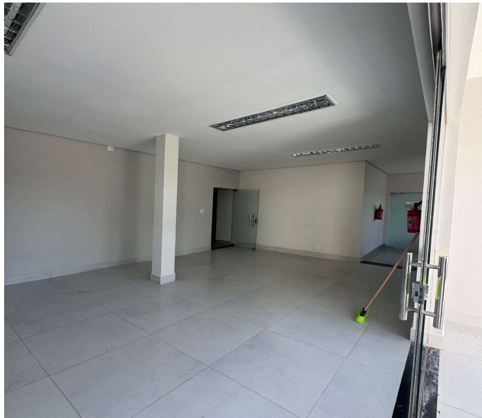
FOTO 36 - ASSENTAMENTO DE PISO. EXECUÇÃO DE PINTURA. INSTALAÇÃO DE PORTAS. INSTALAÇÃO DE EXTINTORES.
