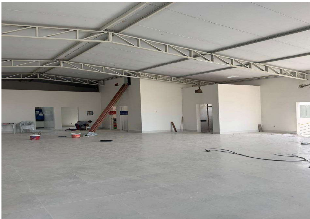
FOTO 19 - ASSENTAMENTO DE PISO E RODAPÉ. EXECUÇÃO DE PINTURA.
