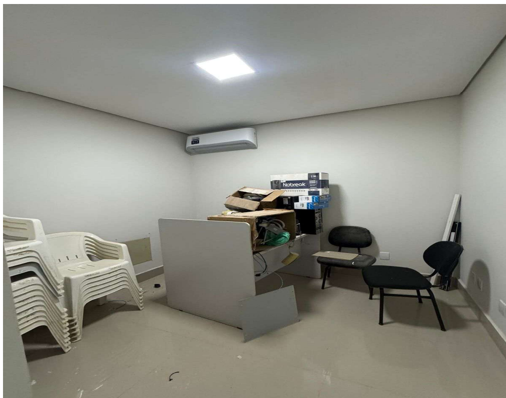
FOTO 24 - EXECUÇÃO DE PINTURA. INSTALAÇÃO DE LUMINÁRIAS. INSTALAÇÃO DE AR-CONDICIONADO.
