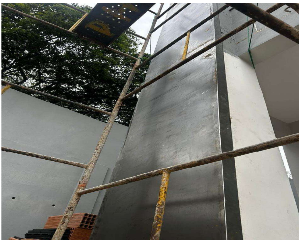
FOTO 16 - INSTALAÇÃO DE PÓRTICO METÁLICO.
