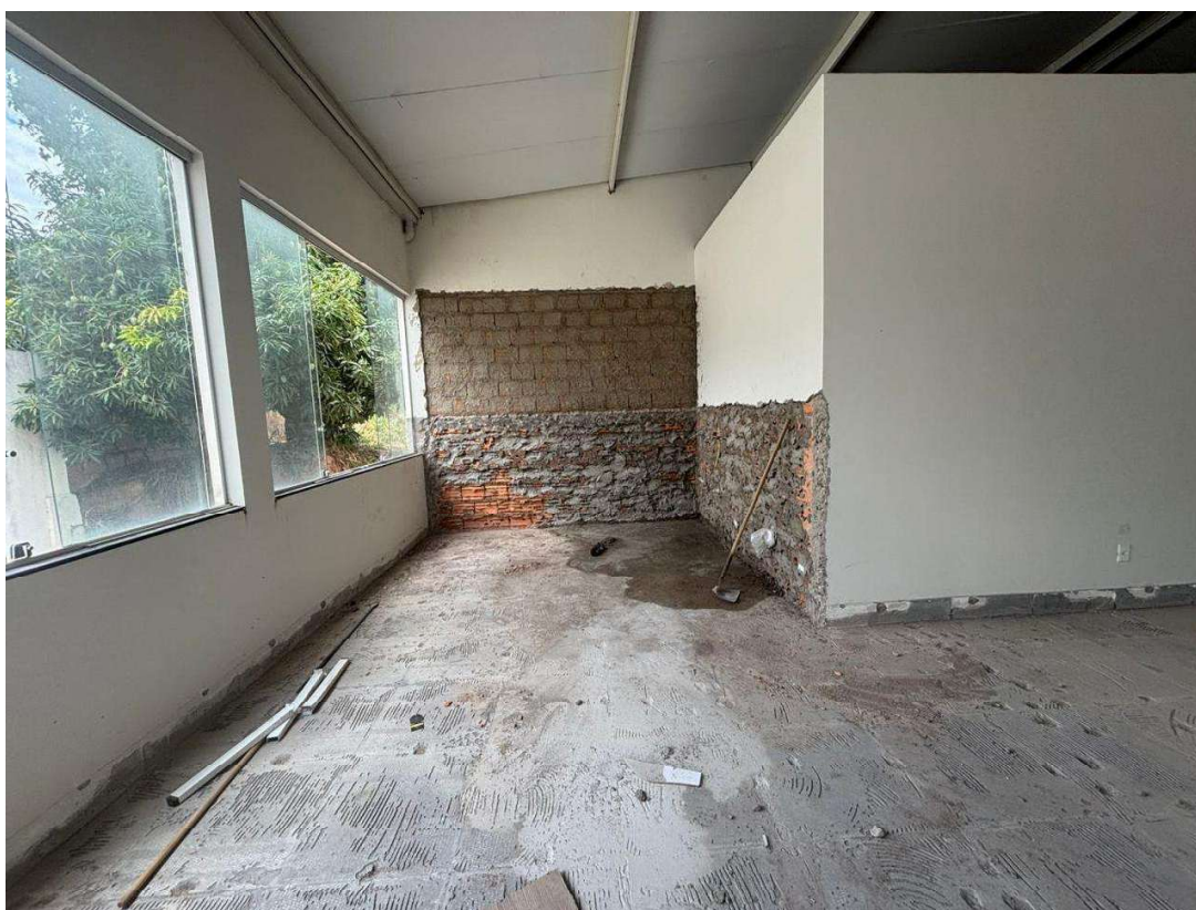
FOTO 4 - EXECUÇÃO DE ALVENARIA, CHAPISCO E REBOCO. REMOÇÃO DE PISO.
