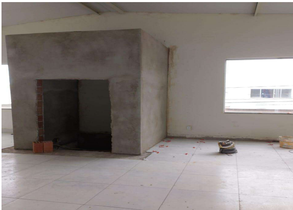
FOTO 11 - EXECUÇÃO DE REBOCO. ASSENTAMENTO DE PISO.
