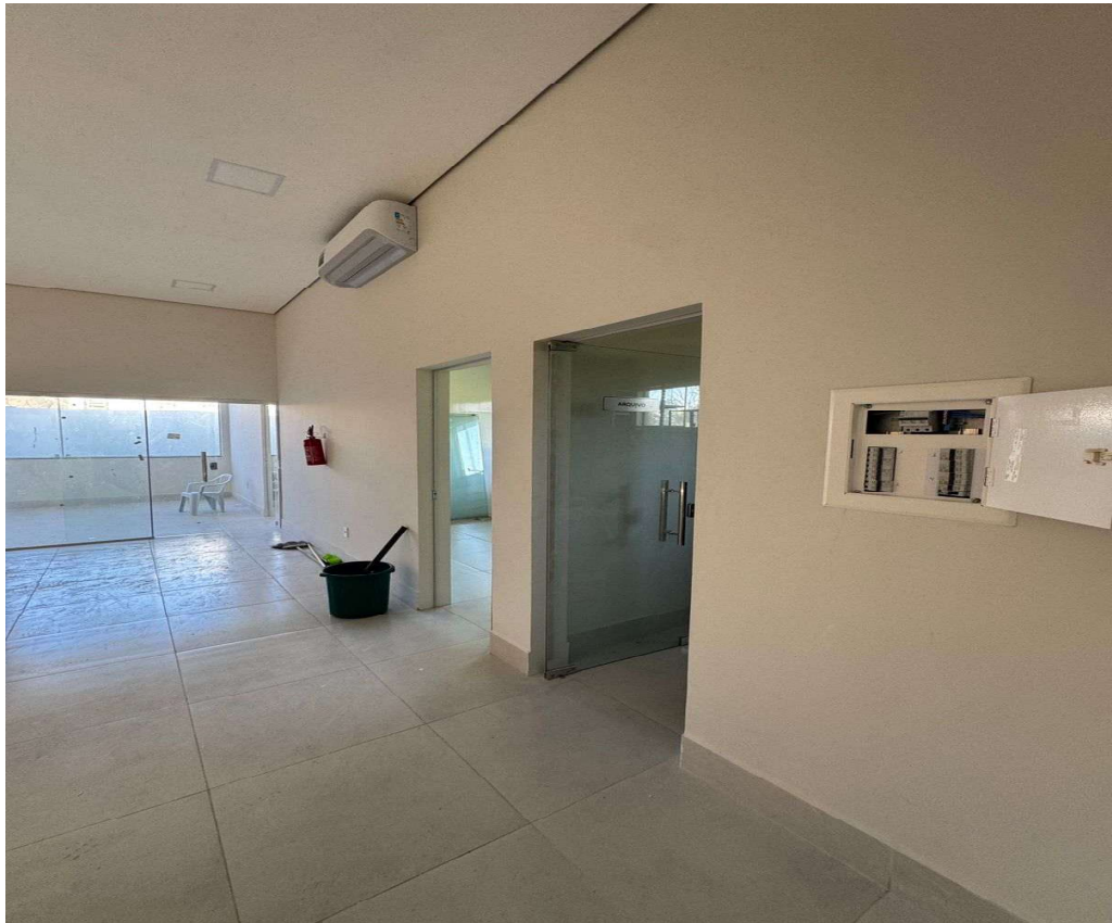
FOTO 41 - EXECUÇÃO DE FORRO EM GESSO E PAREDE DE DRYWALL. INSTALAÇÃO ELÉTRICA. INSTALAÇÃO DE PORTAS. INSTALAÇÃO DE AR-CONDICIONADO. INSTALAÇÃO DE LUMINÁRIAS. EXECUÇÃO DE PINTURA. INSTALAÇÃO DE EXTINTOR DE INCÊNDIO.
