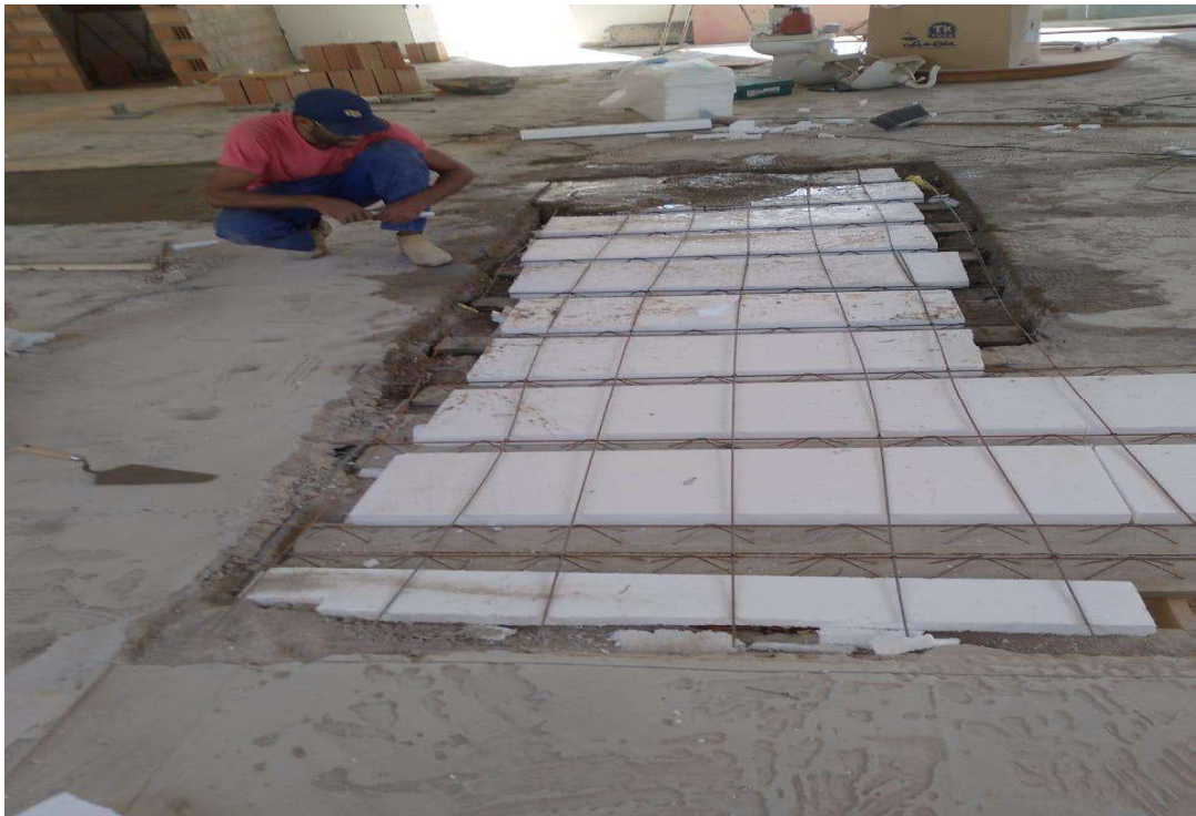
FOTO 7 - EXECUÇÃO DE LAJE.
