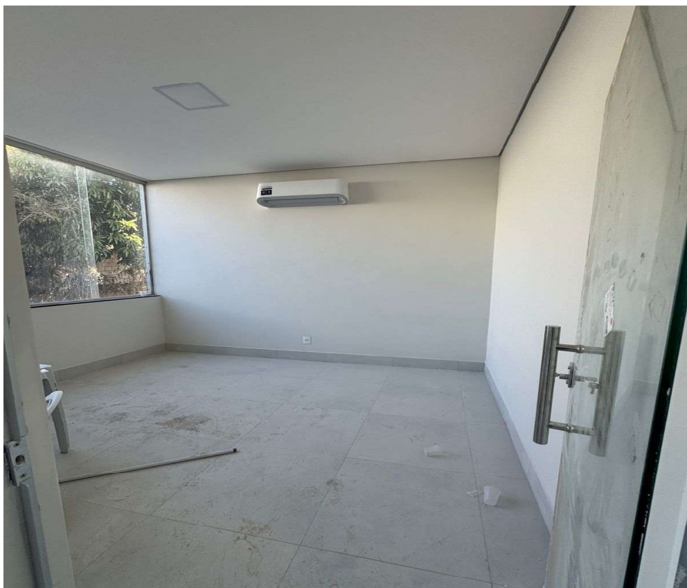
FOTO 39 - EXECUÇÃO DE FORRO EM GESSO E PAREDE DE DRYWALL. ASSENTAMENTO DE PISO E RODAPÉ. INSTALAÇÃO DE PORTA. INSTALAÇÃO DE AR-CONDICIONADO. INSTALAÇÃO ELÉTRICA. INSTALAÇÃO DE LUMINÁRIAS. EXECUÇÃO DE PINTURA.
