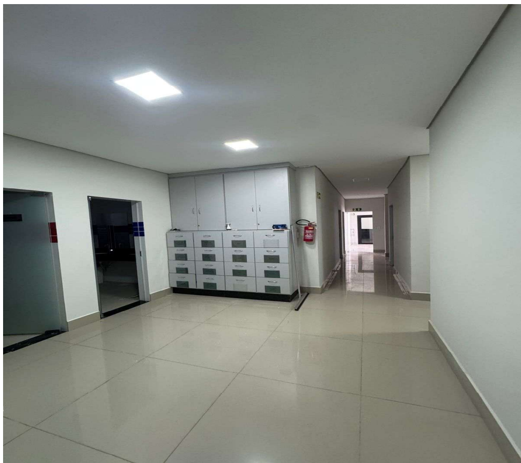
FOTO 23 - EXECUÇÃO DE PINTURA. INSTALAÇÃO DE LUMINÁRIAS. INSTALAÇÃO DE EXTINTORES DE INCÊNDIO E PLACAS DE SINALIZAÇÃO.
