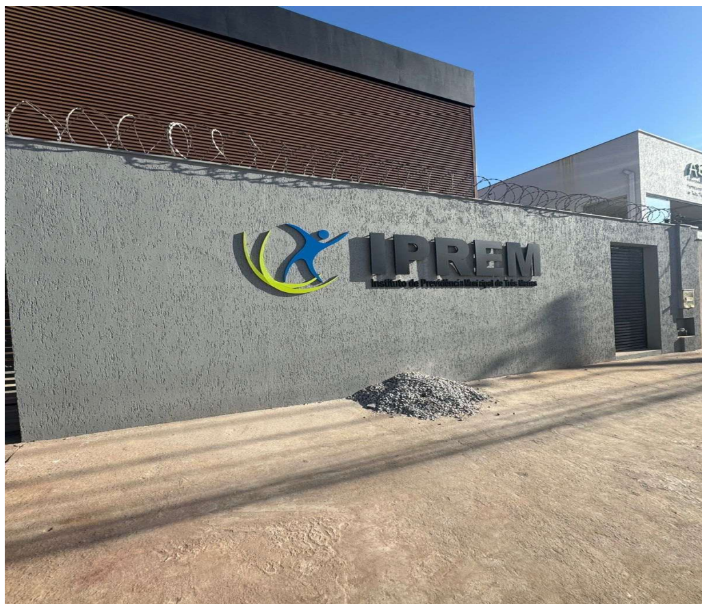
FOTO 49 - INSTALAÇÃO DE LETRAS E PERFIS DE LED. EXECUÇÃO DE PINTURA TEXTURIZADA TIPO GRAFIATO.
