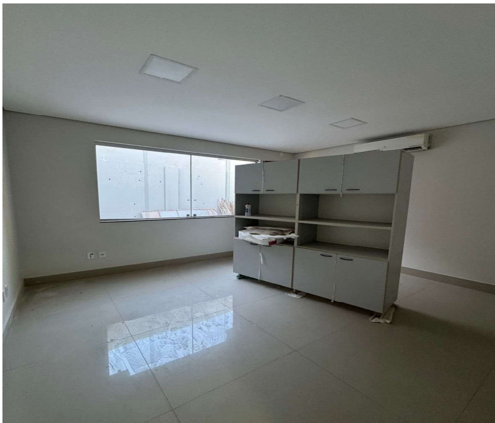
FOTO 25 - EXECUÇÃO DE PINTURA. INSTALAÇÃO DE LUMINÁRIAS.
