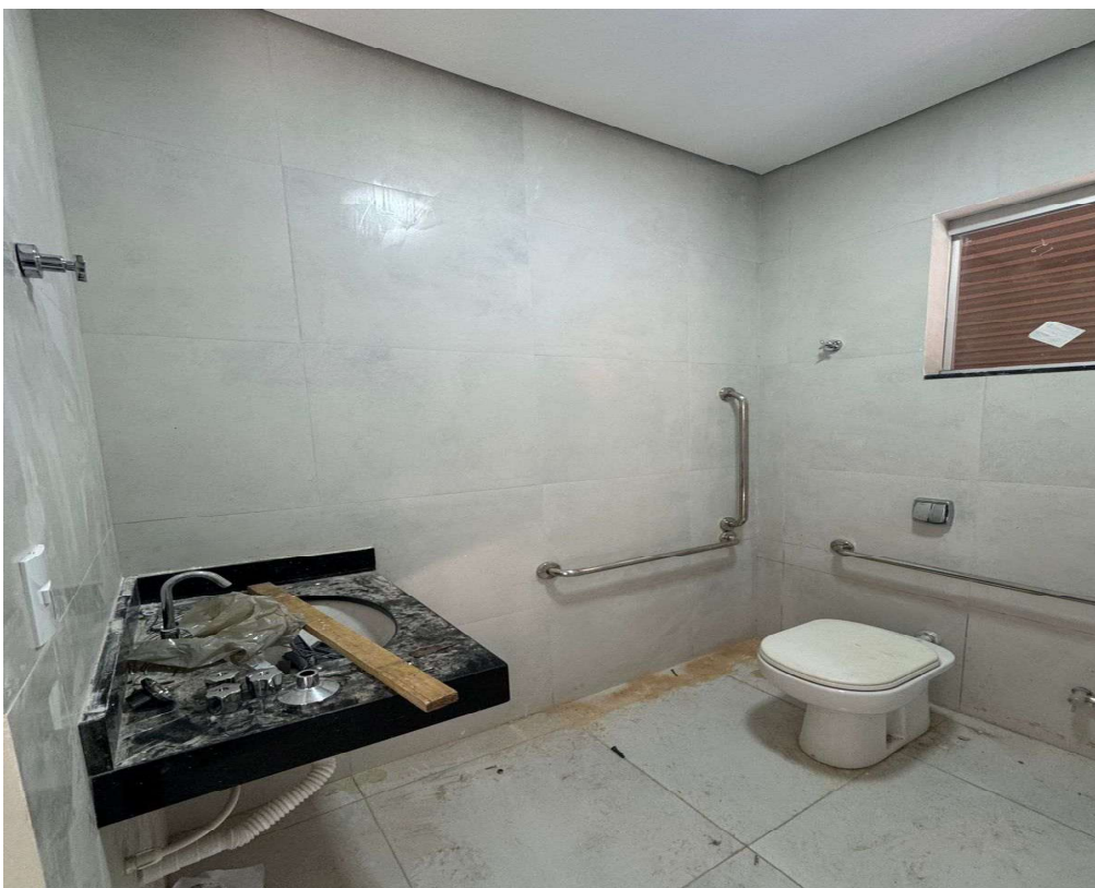
FOTO 44 - ASSENTAMENTO DE PISO. EXECUÇÃO DE FORRO EM GESSO. INSTALAÇÃO DE VASO SANITÁRIO E ACESSÓRIOS. INSTALAÇÃO DE BANCADA E LAVATÓRIO. INSTALAÇÃO DE PORTA E JANELA. INSTALAÇÃO DE LUMINÁRIA. PINTURA.
