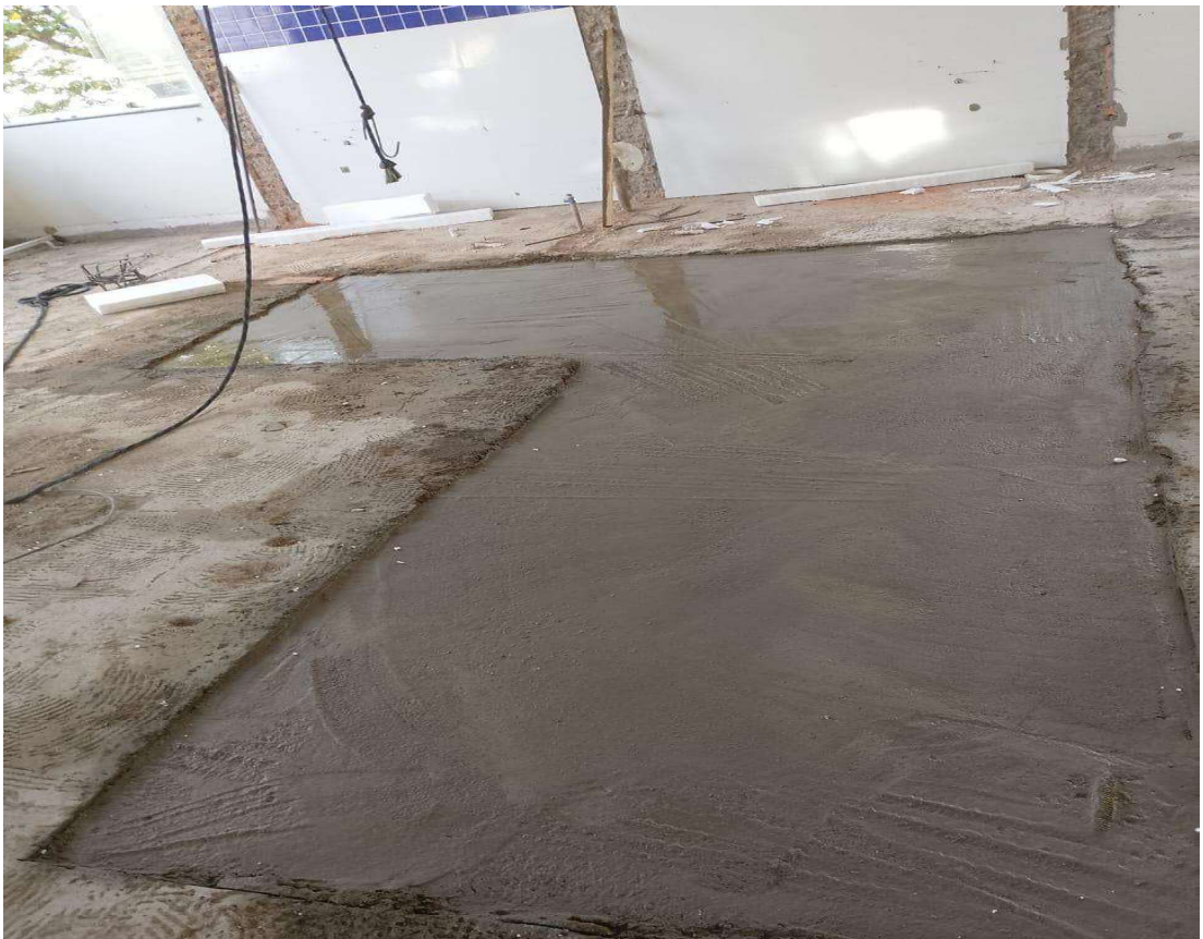
FOTO 8 - CONCRETAGEM DE LAJE.
