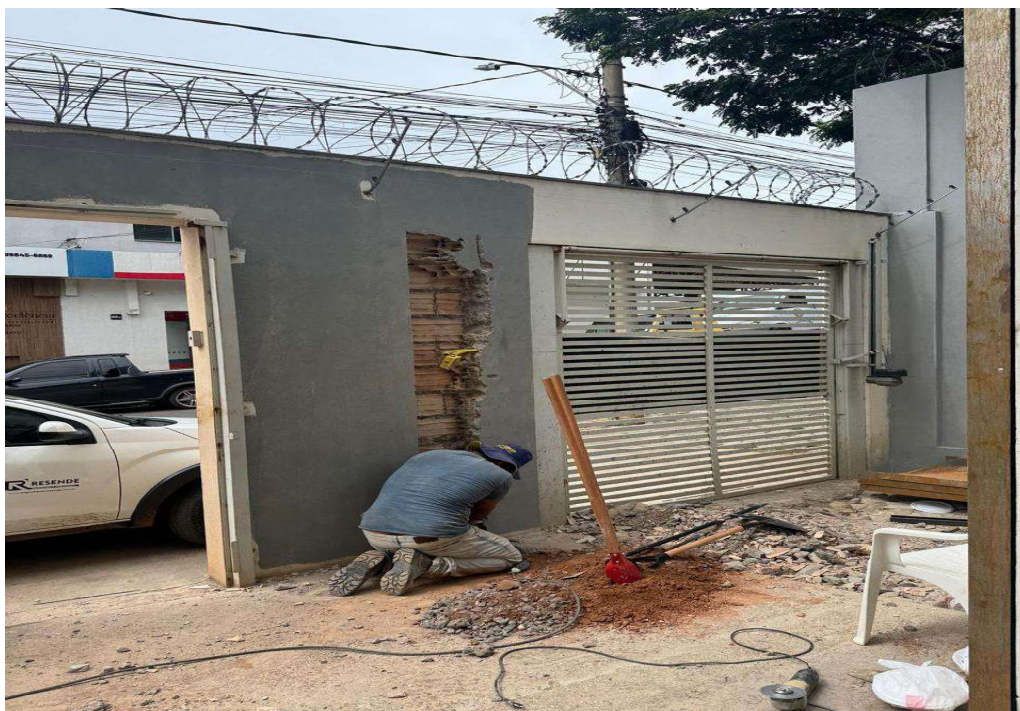
FOTO 13 - EXECUÇÃO DE PILAR PARA AUMENTO DE VÃO DO PORTÃO.
