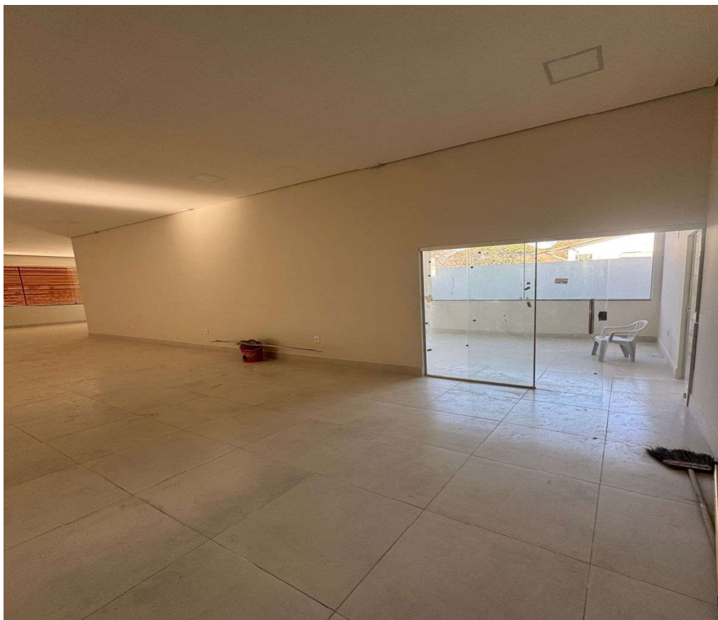
FOTO 45 - ASSENTAMENTO DE PISO E RODAPÉ. EXECUÇÃO DE PAREDE EM DRYWALL. EXECUÇÃO DE PINTURA. INSTALAÇÃO DE PORTA. INSTALAÇÃO DE LUMINÁRIAS.
