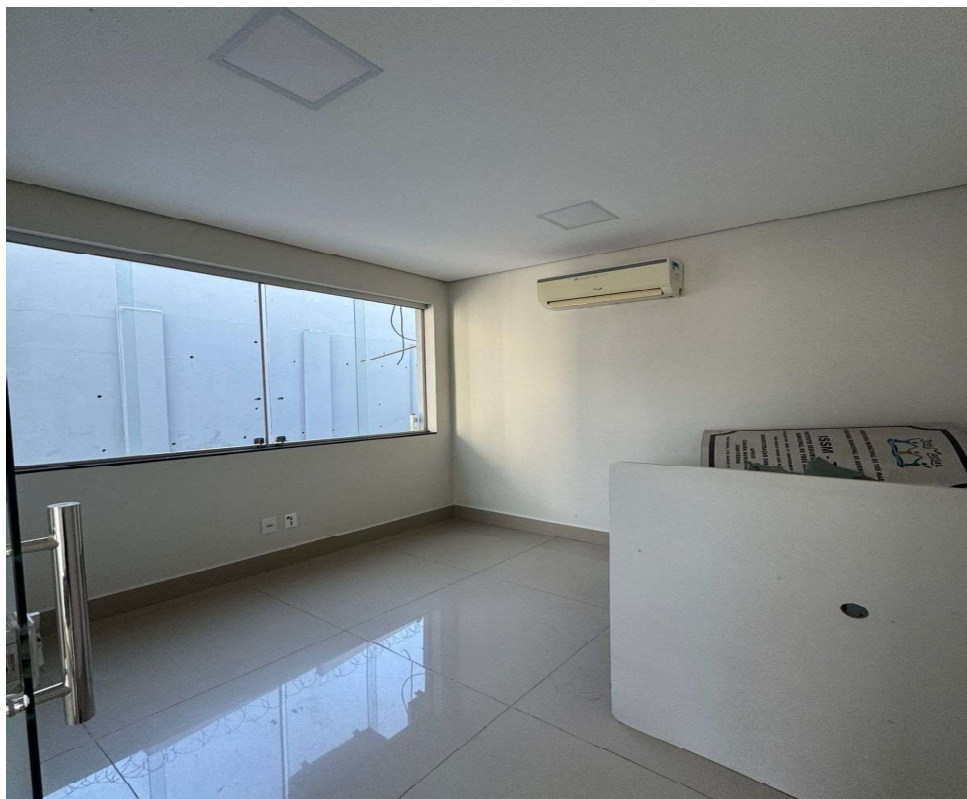
FOTO 31 - EXECUÇÃO DE PINTURA. INSTALAÇÃO DE LUMINÁRIAS. ASSENTAMENTO DE RODAPÉ. INSTALAÇÃO DE PORTA.
