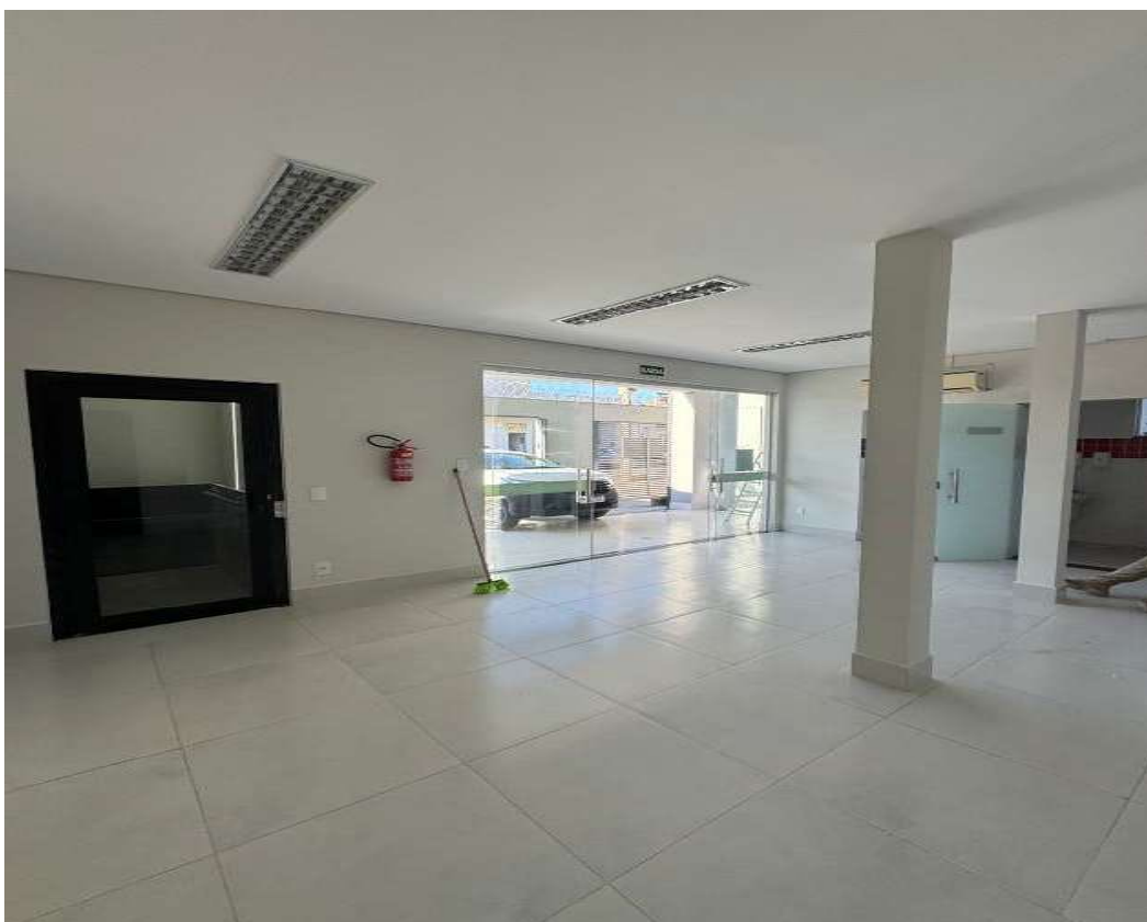
FOTO 18 - INSTALAÇÃO DE PLATAFORMA ACESSÍVEL. ASSENTAMENTO DE PISO E RODAPÉ. EXECUÇÃO DE PINTURA. INSTALAÇÃO DE PORTAS. INSTALAÇÃO DE EXTINTORES DE INCÊNDIO E PLACAS DE SINALIZAÇÃO. INSTALAÇÃO DE LUMINÁRIAS.
