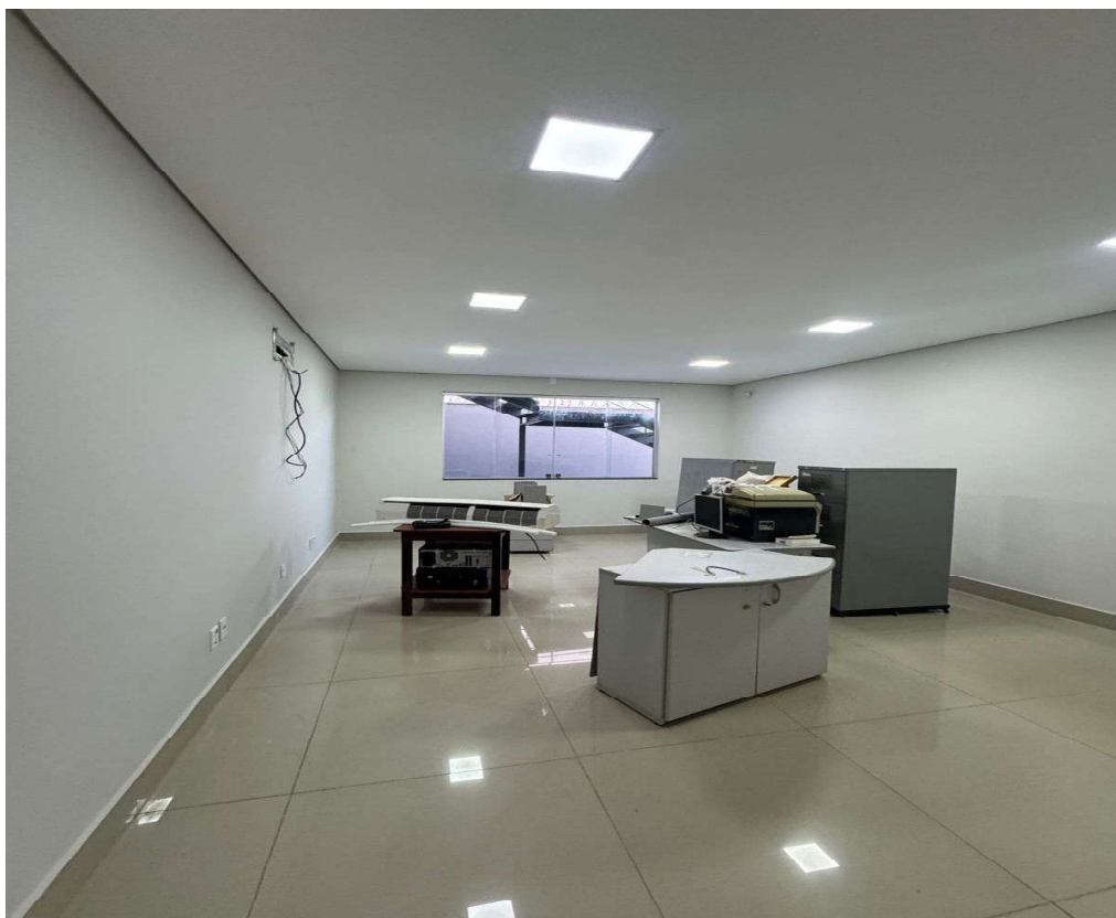
FOTO 29 - EXECUÇÃO DE FORRO EM GESSO. EXECUÇÃO DE PINTURA. INSTALAÇÃO DE LUMINÁRIAS.
