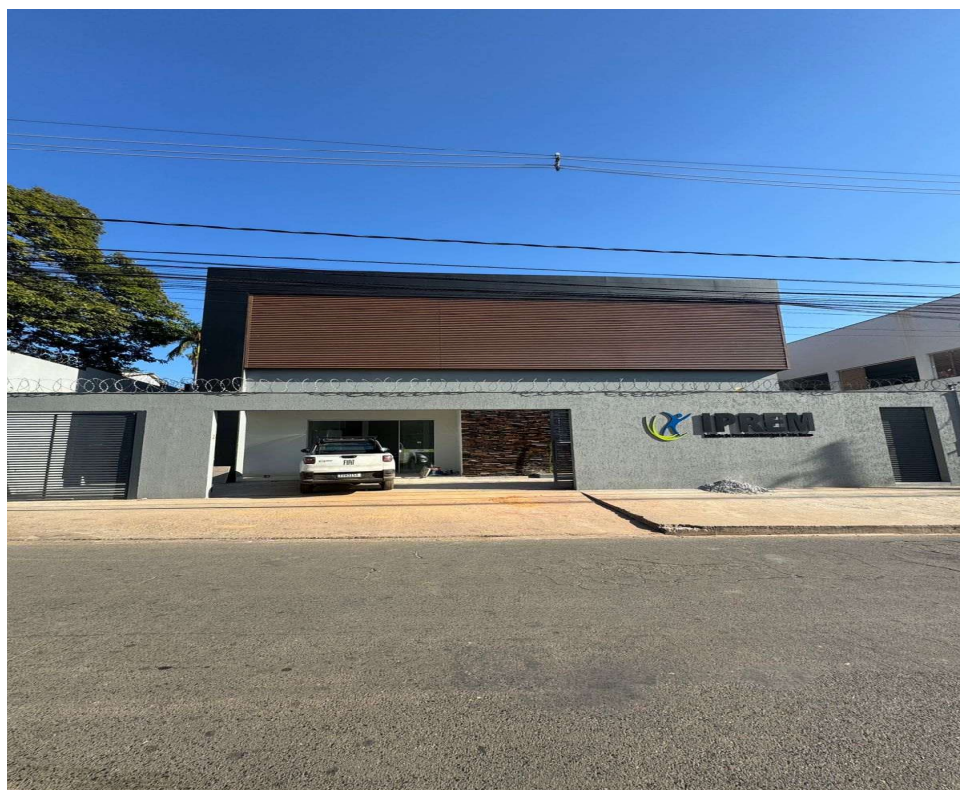
FOTO 50 - INSTALAÇÃO DE PÓRTICO E BRISE METÁLICO. EXECUÇÃO DE PINTURA. INSTALAÇÃO DE LETRAS E PERFIS DE LED.
