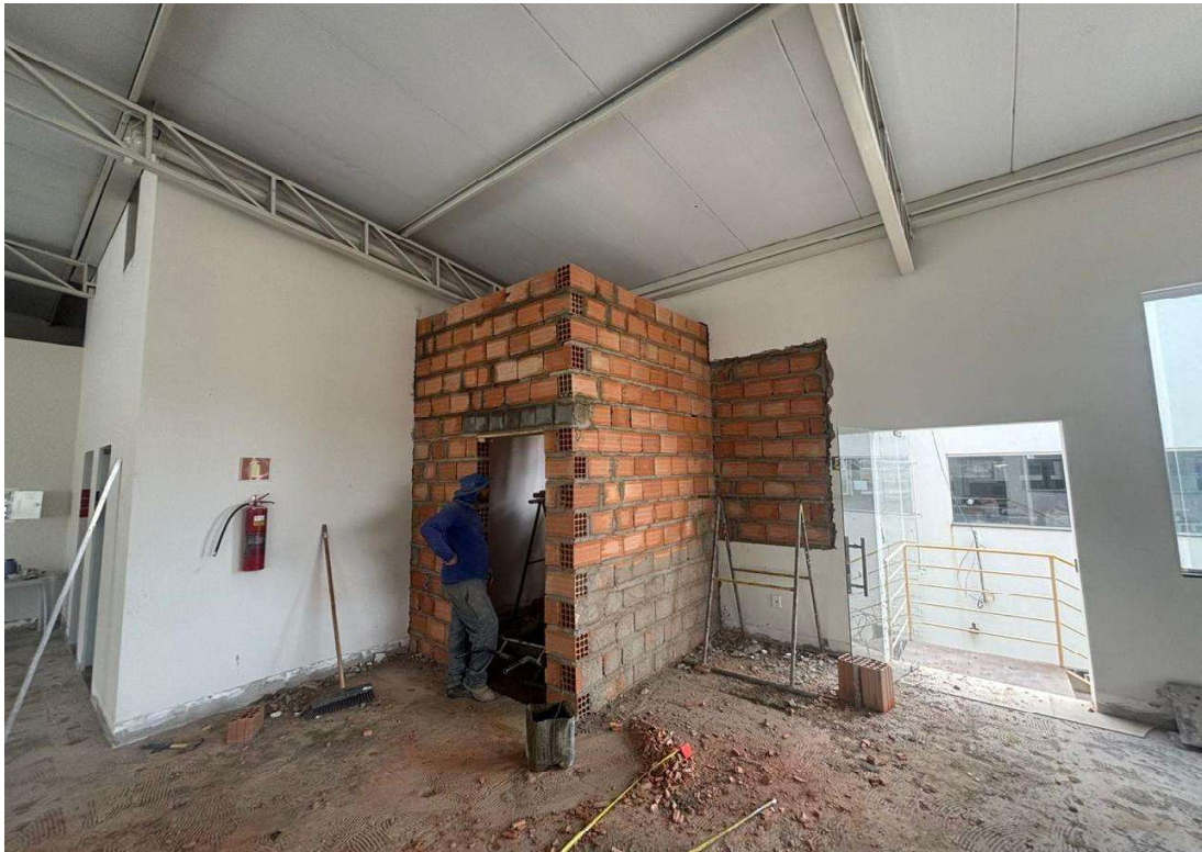
FOTO 5 - EXECUÇÃO DE ALVENARIA. REMOÇÃO DE PISO.
