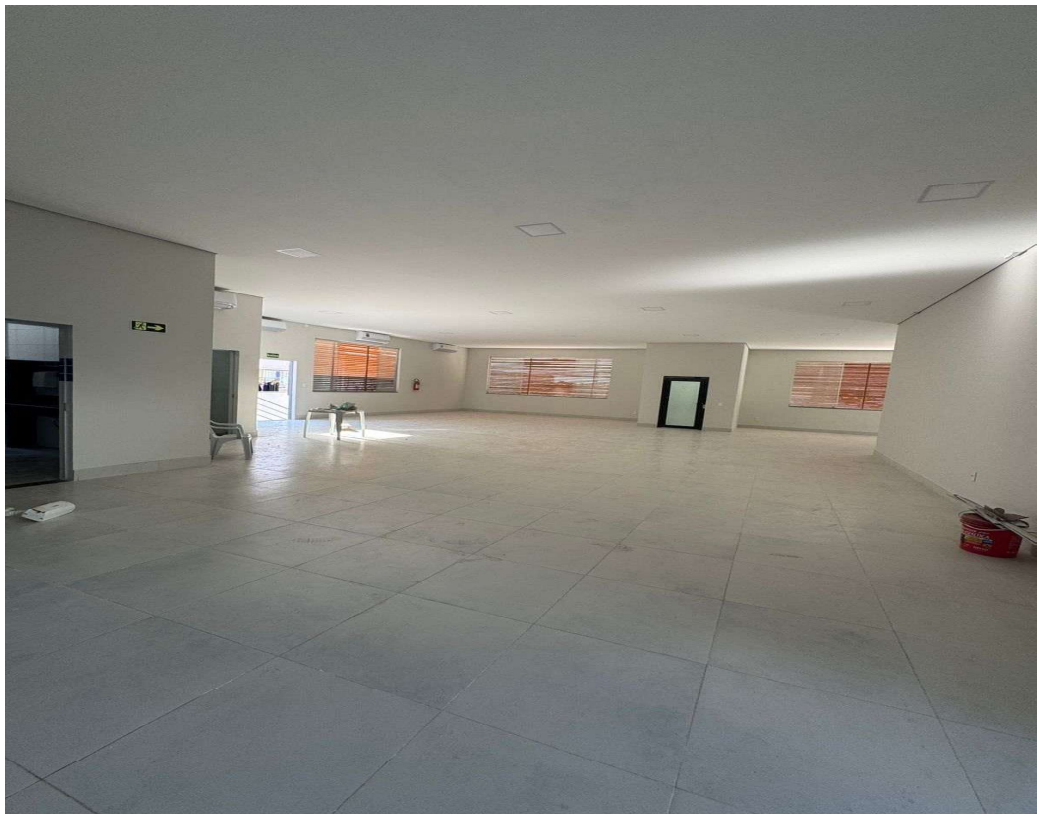
FOTO 42 - ASSENTAMENTO DE PISO. EXECUÇÃO DE FORRO EM GESSO. INSTALAÇÃO DE LUMINÁRIAS. INSTALAÇÃO DE AR-CONDICIONADO. INSTALAÇÃO DE PLACAS DE SINALIZAÇÃO E EXTINTORES DE INCÊNDIO. EXECUÇÃO DE PINTURA.
