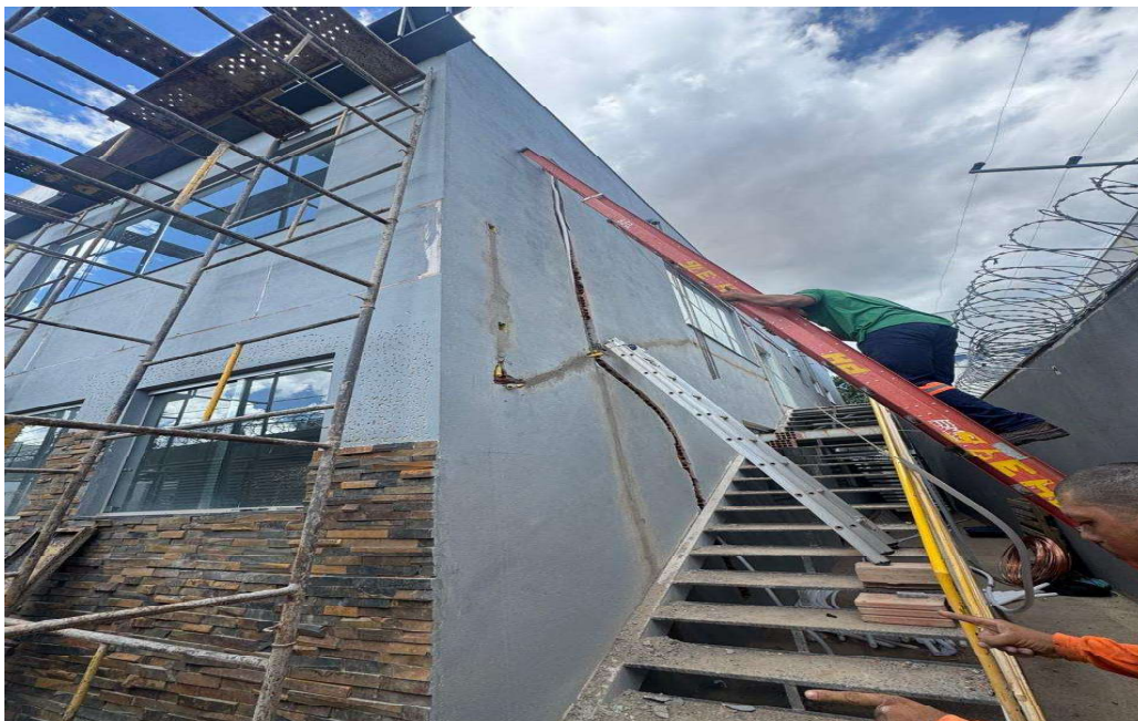
FOTO 15 - INSTALAÇÃO DE PEDRA FERRO. RASGO DE ALVENARIA PARA PASSAGEM DE TUBULAÇÃO ELÉTRICA E DE AR CONDICIONADO.
