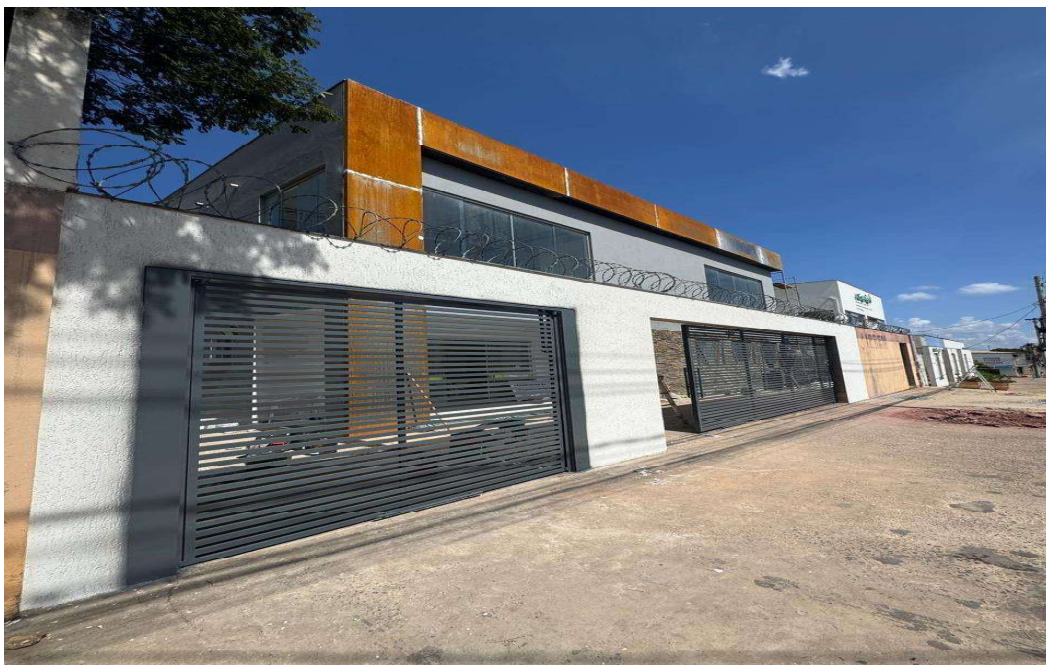
FOTO 17 - INSTALAÇÃO DE PÓRTICO METÁLICO. EXECUÇÃO DE PINTURA DOS PORTÕES.
