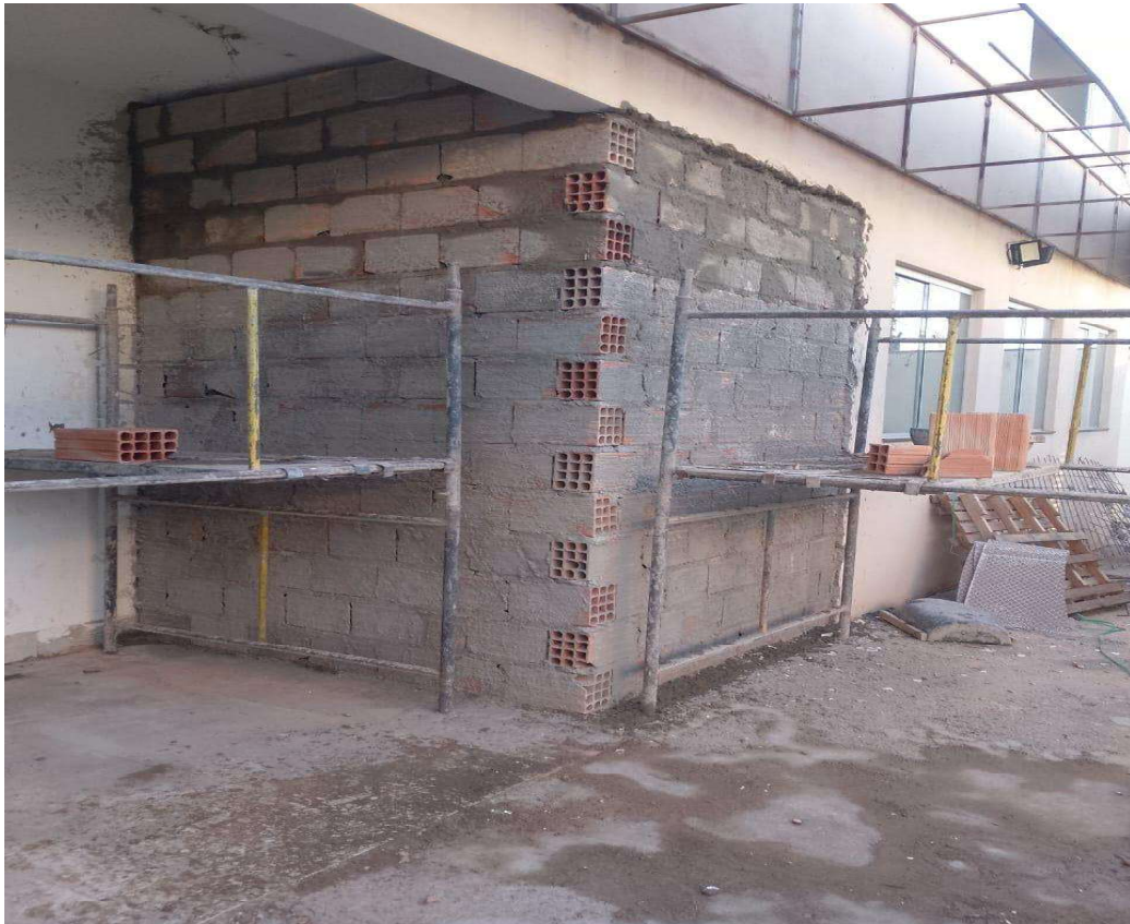
FOTO 10 - EXECUÇÃO DE ALVENARIA, CHAPISCO E REBOCO.
