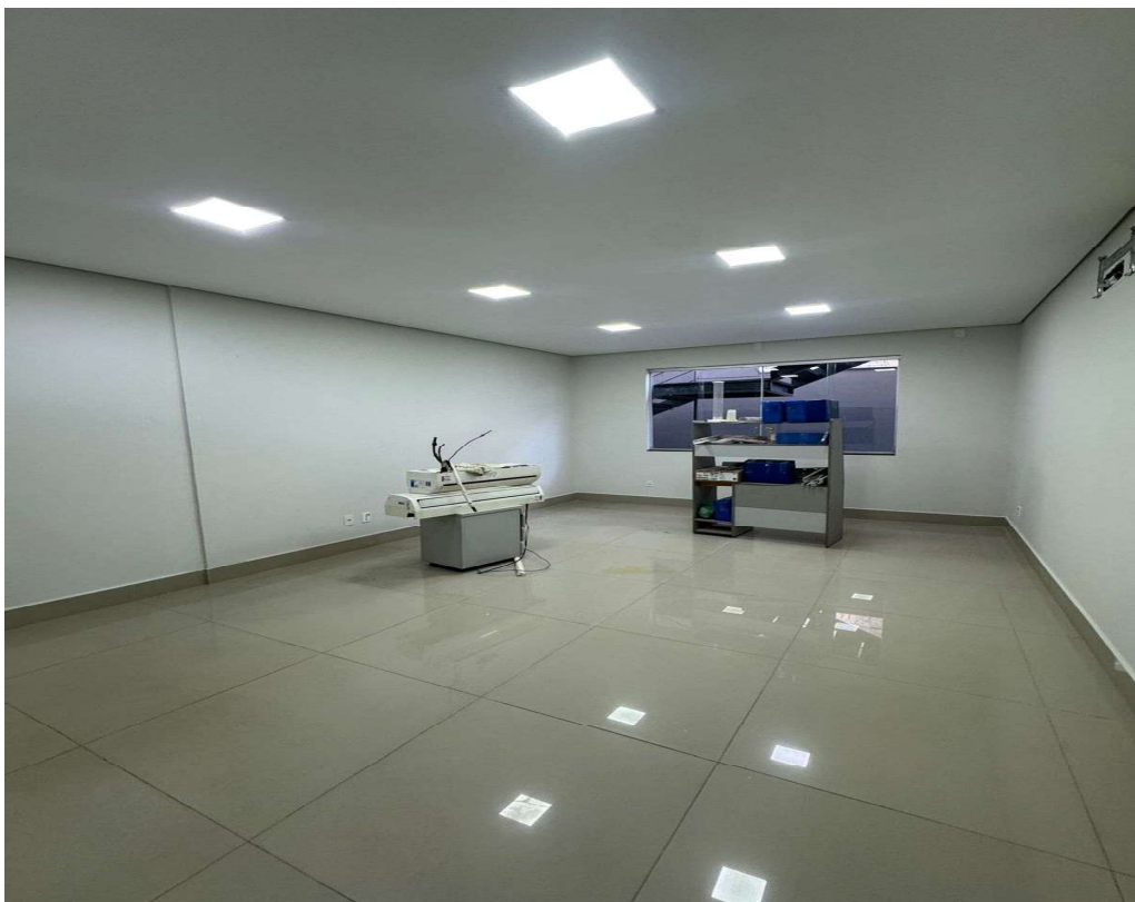
FOTO 27 - EXECUÇÃO DE FORRO EM GESSO. EXECUÇÃO DE PINTURA. INSTALAÇÃO DE LUMINÁRIAS.
