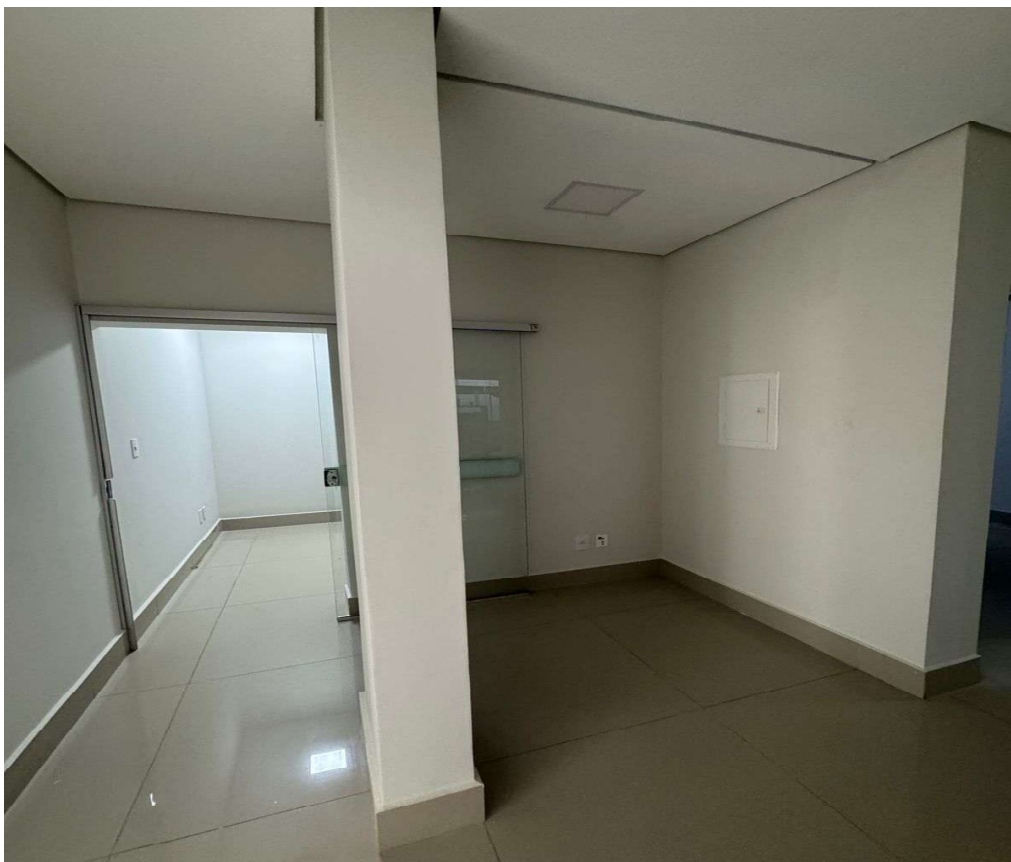
FOTO 28 - INSTALAÇÃO ELÉTRICA. EXECUÇÃO DE PINTURA. INSTALAÇÃO DE LUMINÁRIAS.
