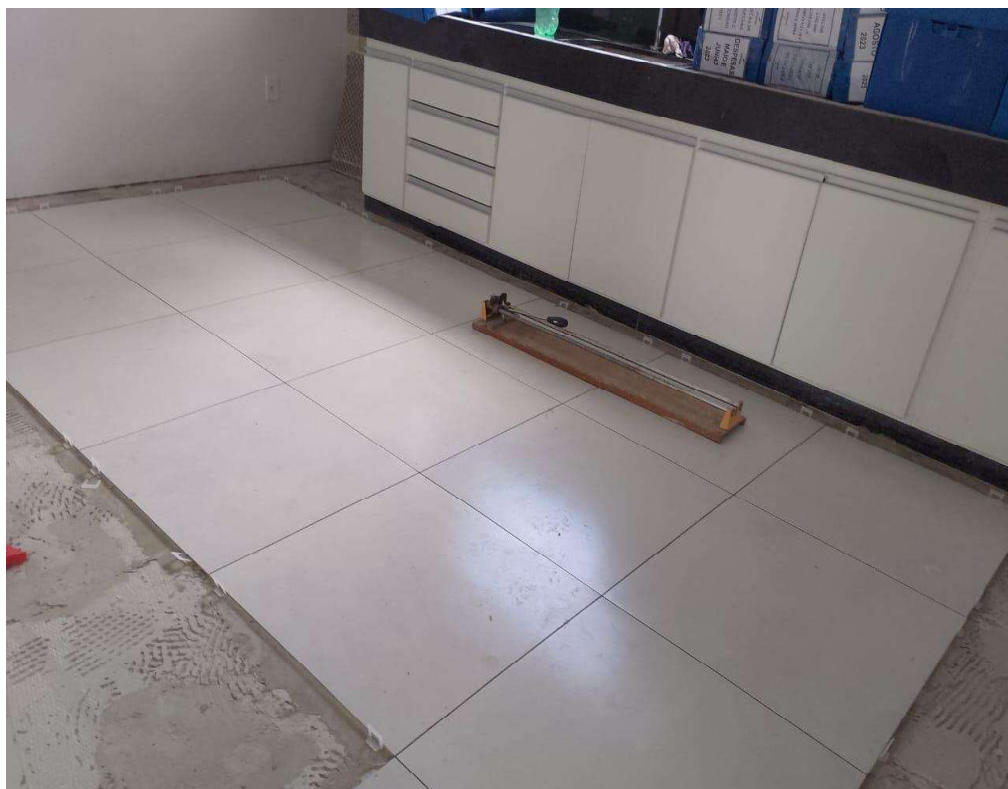
FOTO 12 - ASSENTAMENTO DE PISO.
