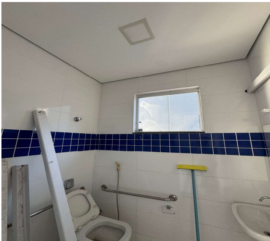
FOTO 33 - EXECUÇÃO DE FORRO EM GESSO. INSTALAÇÃO DE LUMINÁRIA. INSTALAÇÃO DE TUBULAÇÃO PARA AR-CONDICIONADO. EXECUÇÃO DE PINTURA.
